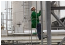
Maschinen- und Anlagenprüfungen
