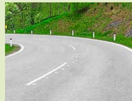
Diese etwas breiteren Markierungen auf der B 95, der Turracherstraße, brachten keine signifikanten Verbesserungen
