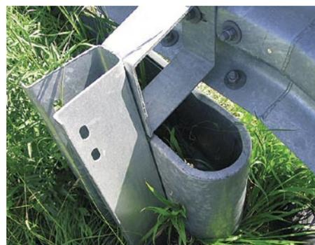
Bild 3: Die End- bzw. Anfangmodule geben der Blechschürze stabilen Halt
