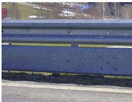
Bild 1: Der Unterfahrschutz, die sogenannte Blechschürze, Vorderansicht
