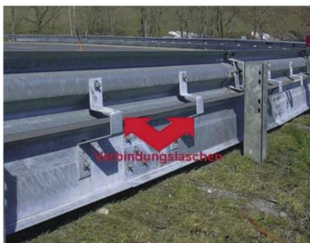
Bild 2: Die Aufhängelaschen an der Rückseite sind einfach zu montieren
